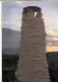
algunas con forma de cono y otras más parecidas a prismas y cilindros; de argamasa, ladrillo o piedra; encajadas o con remate de obra para evitar filtraciones de agua.
